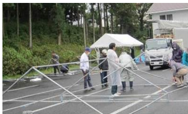
西中山自治区民会館屋外設営準備
