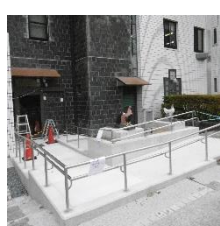
▲職員通用口に繋がる スロープ
